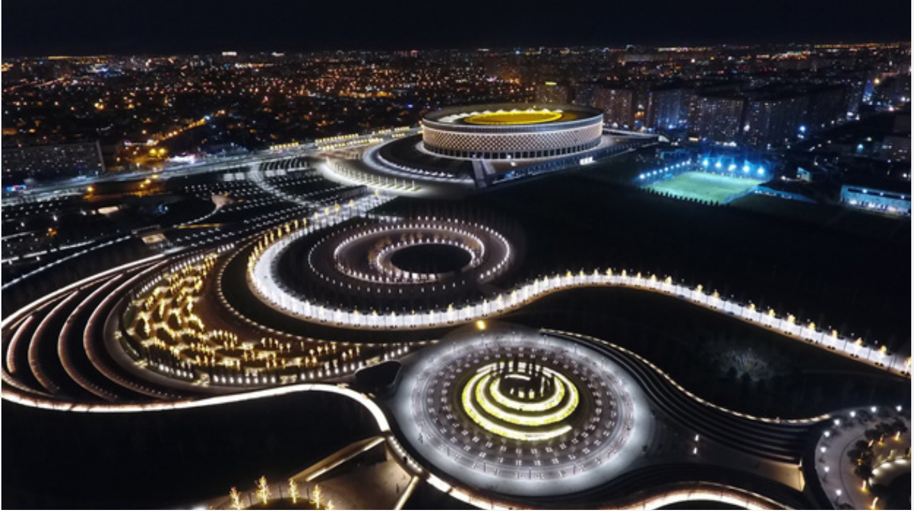
ESTA İNŞAAT tarafından inşa edilen KRASNADOR STADYUMU
